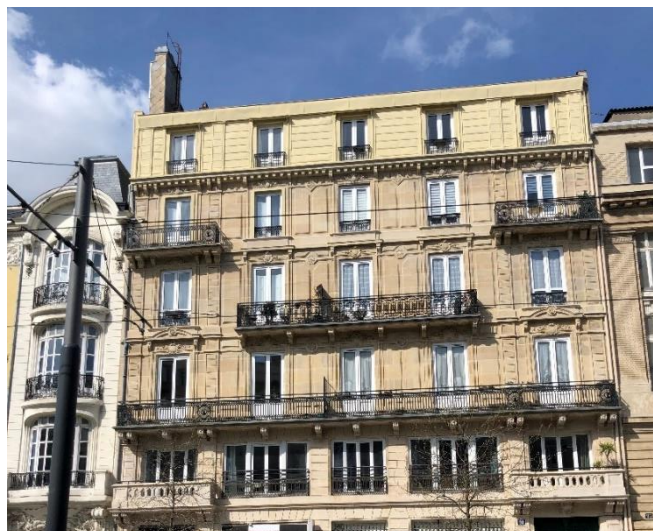
Cette résidence, située boulevard de Strasbourg au Havre, sera proposée en bail réel solidaire dès septembre 2019.
